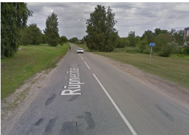
3-15. ATTĒLS. RŪPNIECĪBAS IELA JEB VALSTS REĢIONĀLĀ AUTOCEĻĀ P25 VIRZIENS
